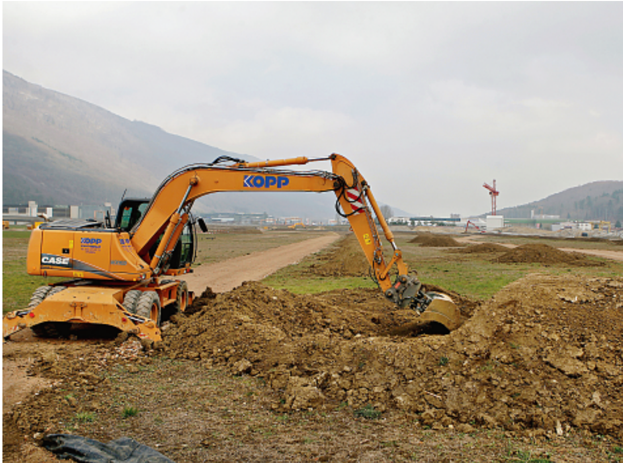
Die Bagger sind da, aber es wird nicht gearbeitet: die verlassene «Stades-de-Bienne»-Baustelle im Bözingenfeld.
